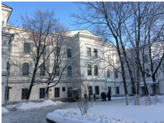
Рис. 4. Современный вид главного здания бывшего Мариинского института (ныне корпус НГТУ им. Р.Е. Алексева). Фото Н.А. Пакишиной.
