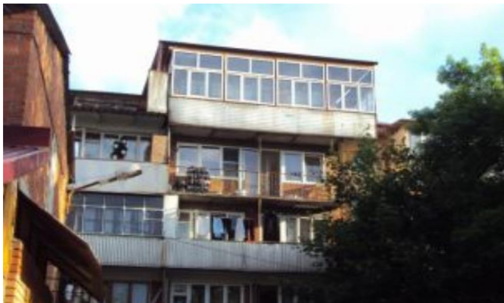
Рис. 3. Жилой дом в 4-м микрорайоне г. Владикавказ
