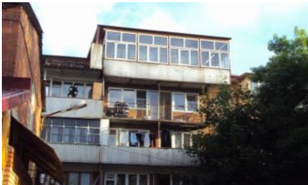
Рис. 3. Жилой дом в 4-м микрорайоне г. Владикавказ
