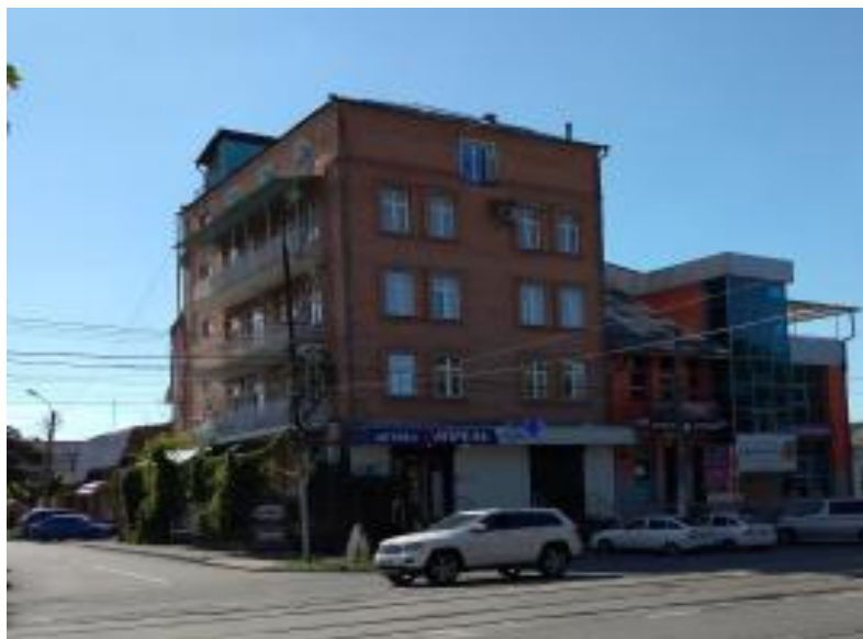
Рис. 7. Надстройка над домом по пр. Коста
